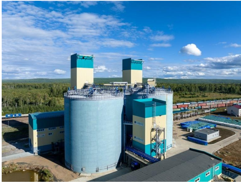
Строительство Тайшетского Алюминиевого завода
